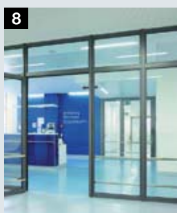
8 Prvky protipožárního a kouřotěsného trubkového rámu
