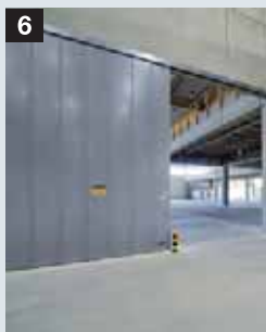
6 Protipožární posuvná vrata
